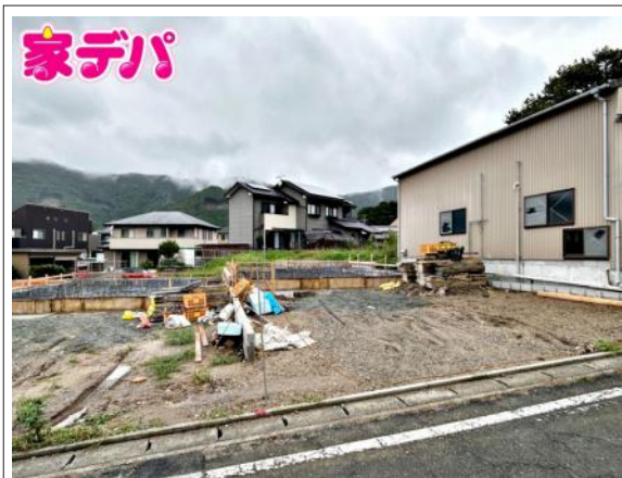
写真 【6号棟】基礎工事中です！・日当たり良好南向き・3LDK
